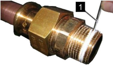
Abb. 9: Dichtfaden aufbringen
