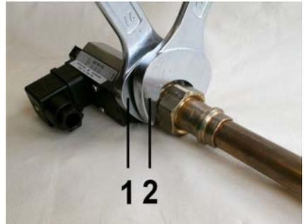
Abb. 11: Gerät einschrauben
